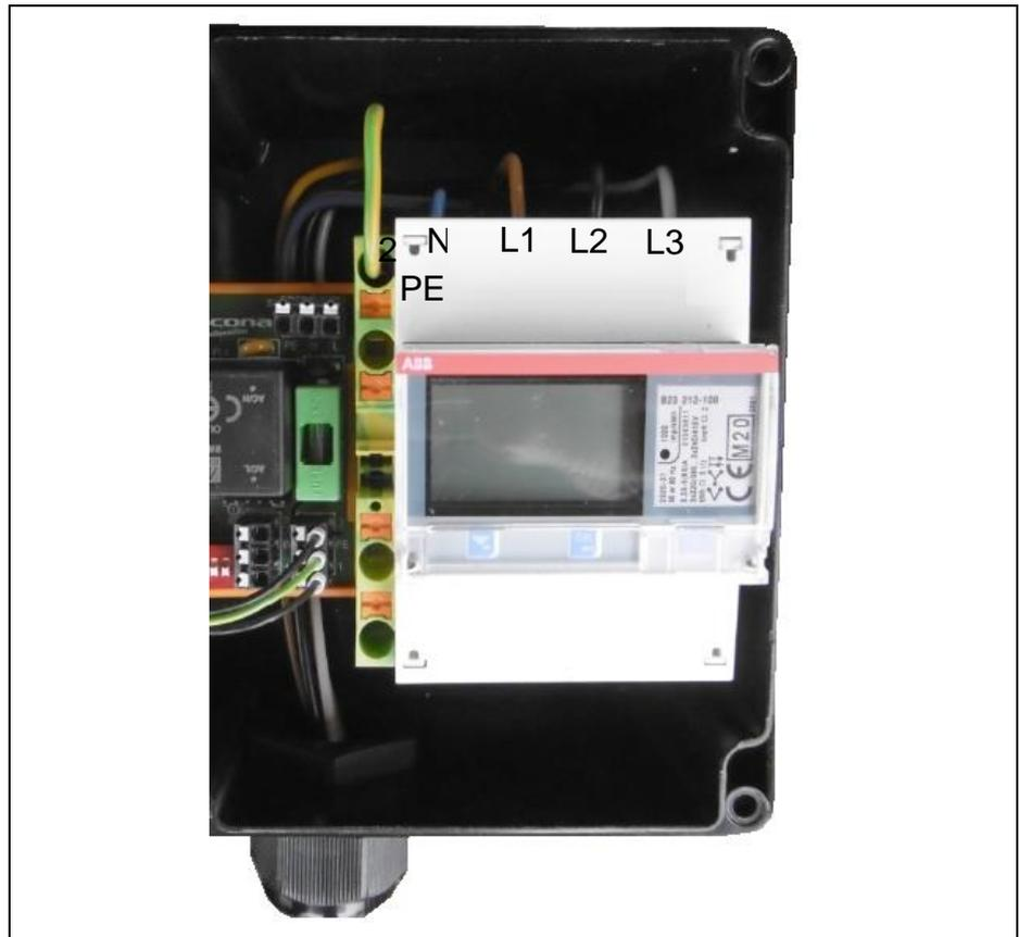
Die Zuleitung wird von unten durch die M32 Kabelverschraubung eingeführt. Die Adern sind hinter dem Laderegler nach oben zu führen. Der PE-Anschluss erfolgt an der grün-gelben Klemme. Die drei Phasen und der Neutralleiter werden direkt von oben am Energiezähler angeschlossen.
